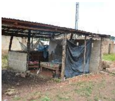
Poste mixte de Sokoro
